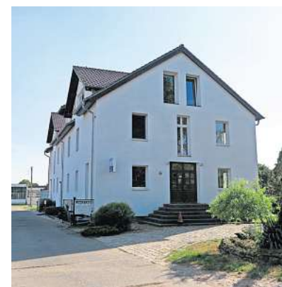
Dieses Wohngebäude in Neuendorf bei Brück hat zunächst Interesse geweckt. Nun ist auch das Gelände dahinter verkauft.
